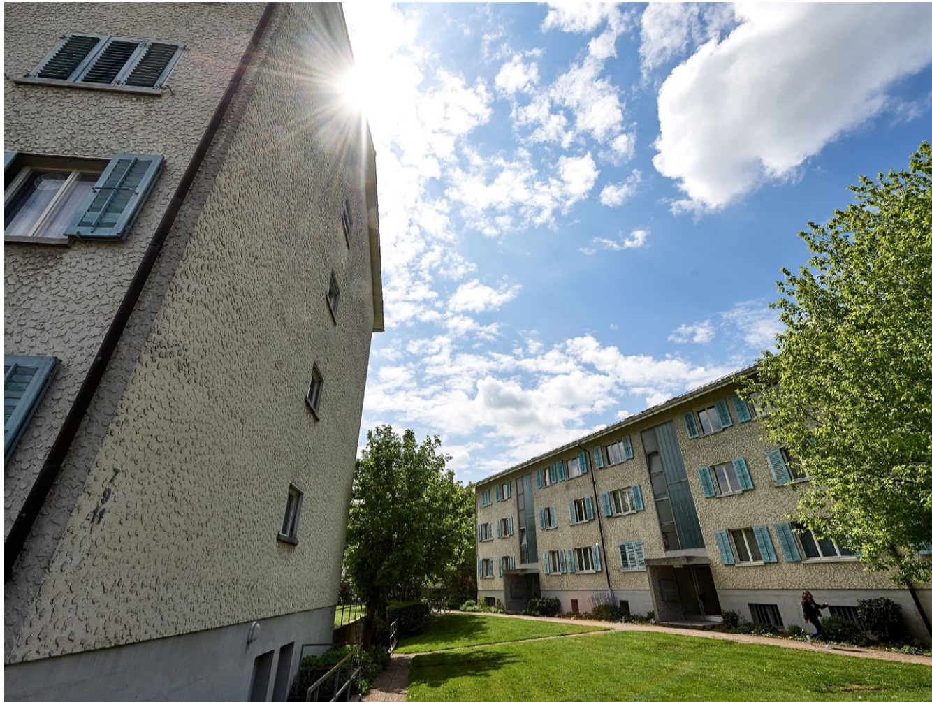
Frühlingssonne über dem Quartier Thomasweg: Sagt das Volk Ja, entsteht hier eine neue, dichte Siedlung. Foto: Adrian Moser
